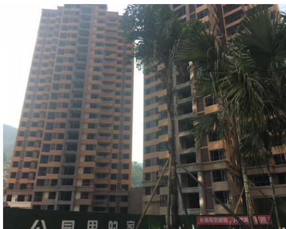
图 8-1 10#、11#楼整体建筑图图
