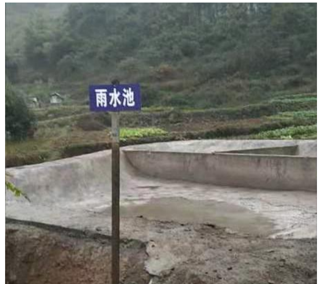
初期雨水收集池
