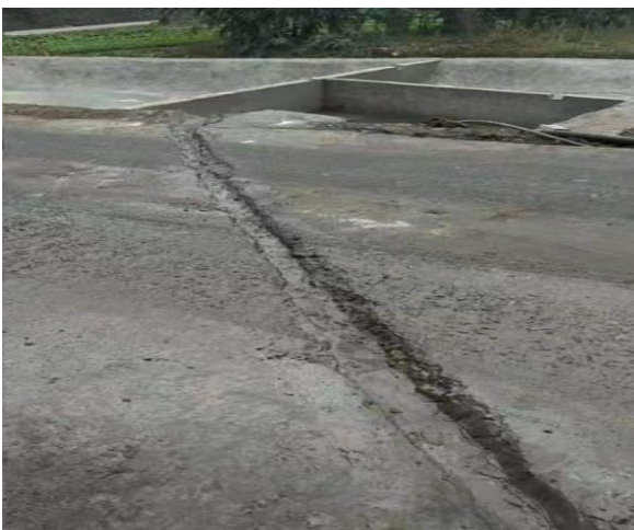
厂区外雨水沟
